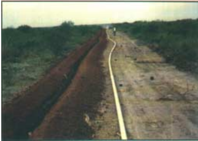
Zapata, Texas Tubería de Conducción de 2", 2½", 3" y 4" a 1500 lb/plg 2 .
