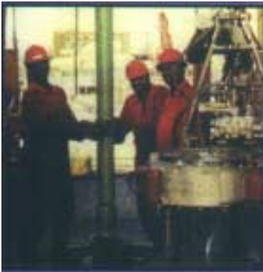
Dubai, 1992. Casing Star de 5 \frac{1}{2} " a 2,000 lb/plg 2 para pozo de observación con corrida de 127 a 2,836 m a 112.7° C.
