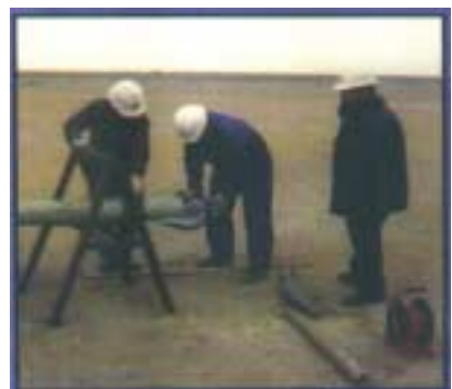
Devastando una línea de tubería de 6" y 8" Kazakhstan - 2000
