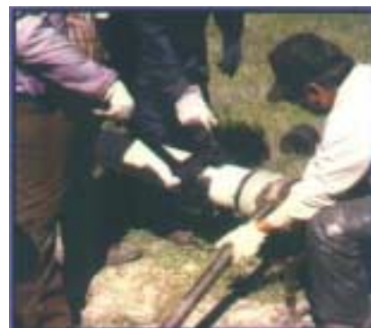
Herramientas especiales de fácil manejo son empleadas en esta instalación de tubería de 8" para una línea de transferencia de agua salada cerca de refugio, Tx
