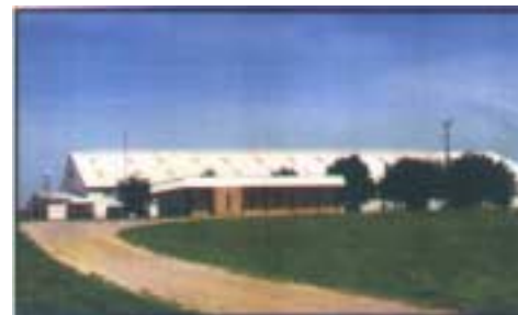
Planta de fabricación de Tubería y Accesorios en Big Spring, Texas
